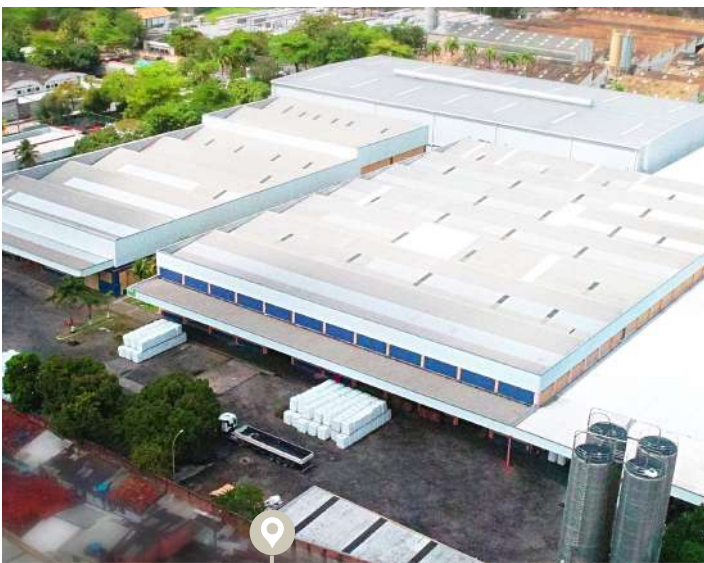
Unidade Fabril Recife | manufacturing unit | Unidad fabril
